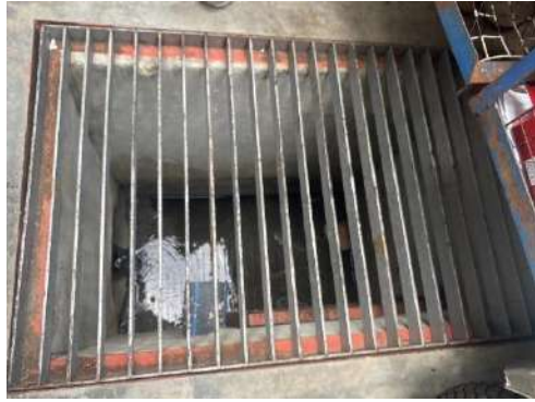
รูปที่ 26 ตะแกรงดักขยะบ่อบำบัดก่อนออกจากโครงการ
