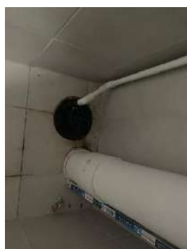
รูปที่ 10 ท่อรวบรวมน้ำเสีย
