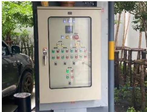
รูปที่ 28 ตู้ควบคุมระบบบำบัดน้ำเสียและมิเตอร์น้ำเสีย
