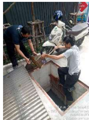
รูปที่ 59 การขุดลอกตะกอนระบบระบายน้ำภายในโครงการ
