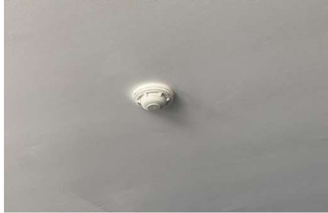
รูปที่ 51 เครื่องตรวจจับควัน ภายในห้องเครื่องไฟฟ้า
